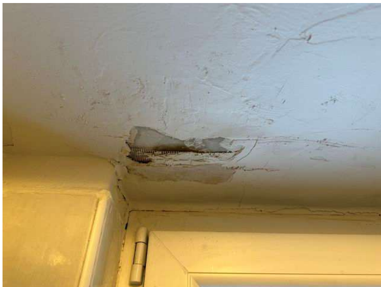
Foto 1: Pohled na vlhkostní projevy u nadpraží okna v kabince na dámských záchodcích
