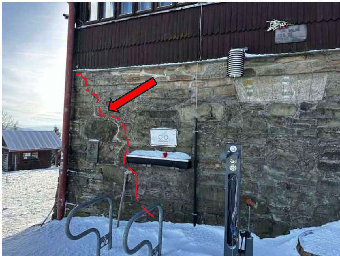
Foto 23: Pohled na severní roh objektu, vyznačení viditelně opravovaných spár kamenného zdiva
