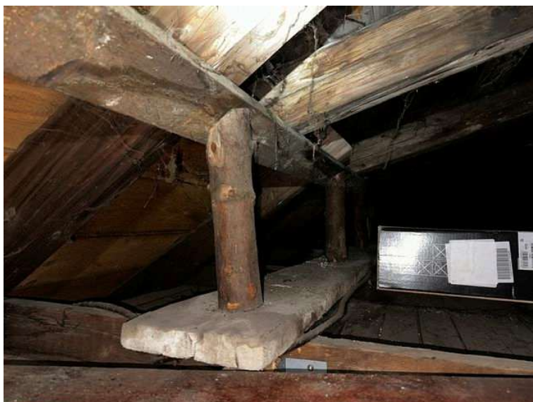
Foto 10: Pohled na neodborné podepření krokové soustavy, použití neodkorněné kulatiny
