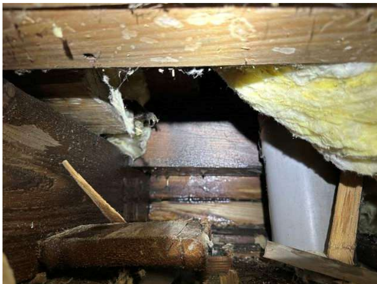
Foto 3: Pohled na střechu v místě sondy S1 – absence opracování prostupujících kruhových prvků
