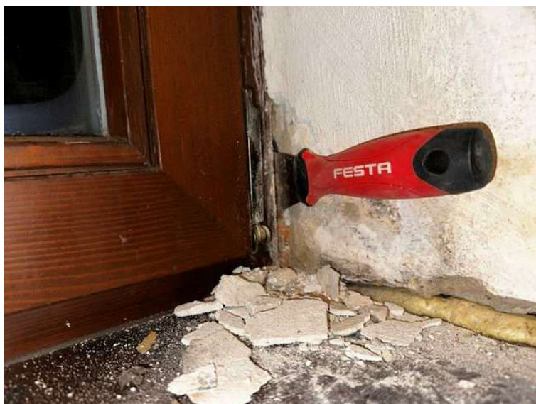
Foto 17: Pohled na opravování připojovací spáry a její netěsnost
