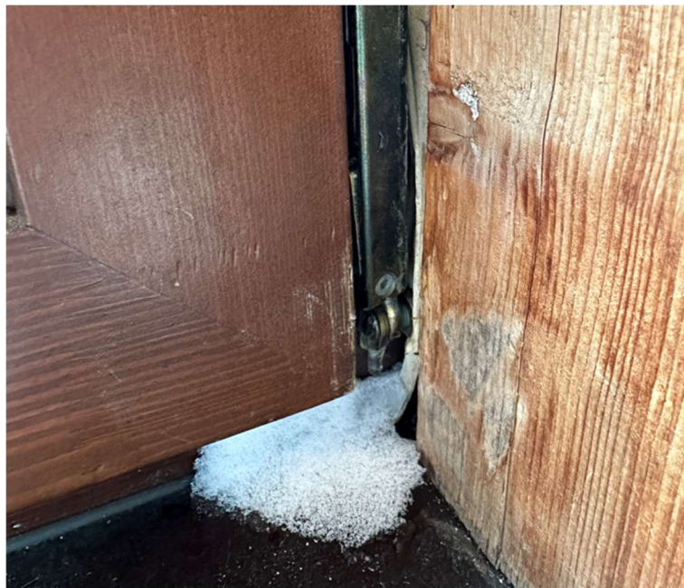
Foto 15: Pohled na sněh na vnitřním parapetu okenní výplně, netěsnost připojovací spáry
