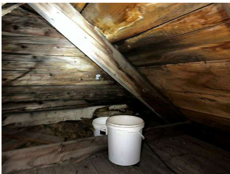
Foto 11: Pohled na použití kyblíků pro zachycení úkapů srážkové vody
