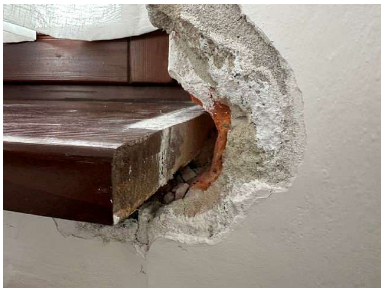
Foto 21: Pohled na opravování parapetní desky (dutina mezi parapetem a zdívem nevyplněná, vede k degradované pěně v přípojovací spáře)
