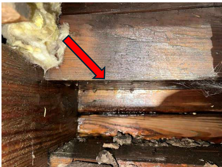
Foto 4: Pohled na tvorbu úkapů na pozednici, v zimním období úkapy zamrzají
