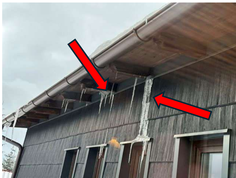
Foto 6: Pohled na střechu u okapu – tvorba ledových valů a rampouchů
