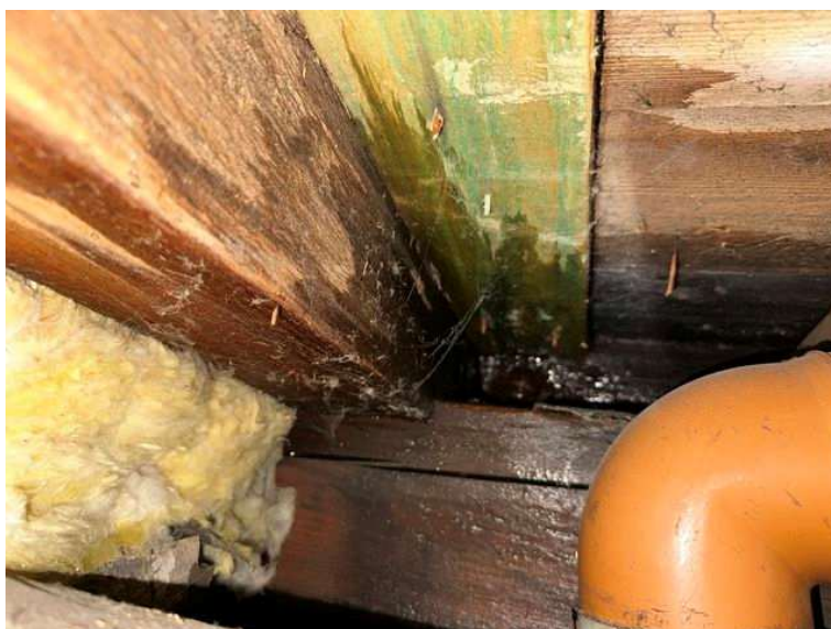
Foto 5: Pohled do místa provedené sondy S1 – šířící se vlhkost od okapu střechy a v blízkosti prostupů střechou
