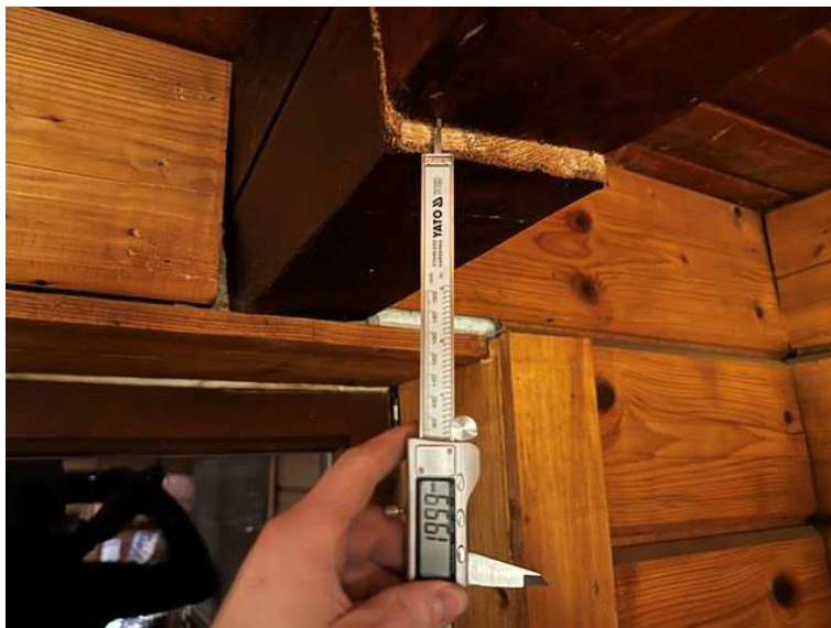
Foto 25: Pohled na pohyby části falešných trámů v blízkosti severovýchodního rohu objektu
