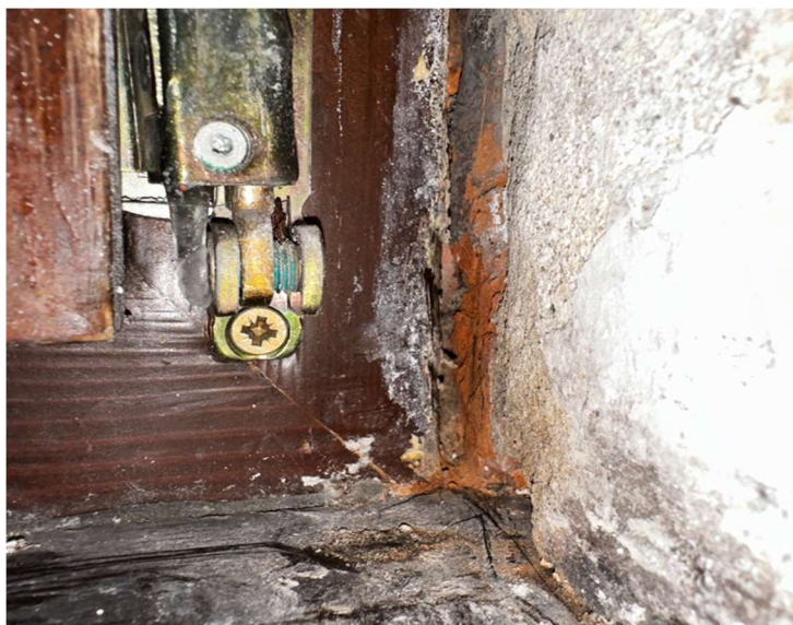
Foto 16: Pohled na opravování připojovací spáry a její netěsnost
