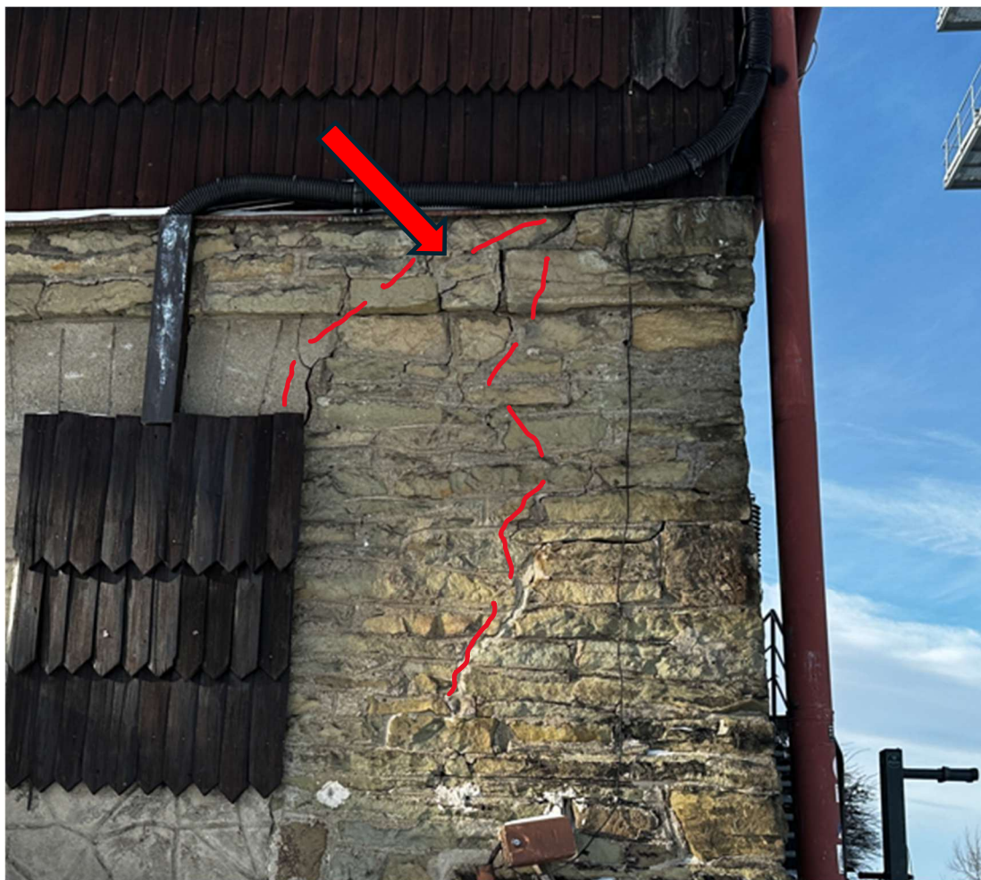
Foto 24: Pohled na jižní roh objektu, tvorba trhlin od překladu k rohu objektu
