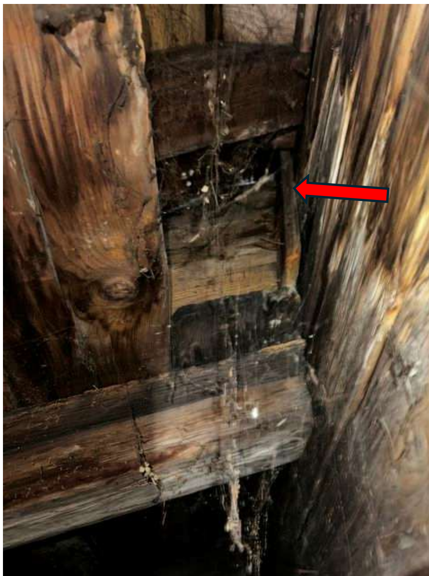
Foto 12: Pohled na degradovanou část dřevěných prvků střechy, destrukce části bednění
