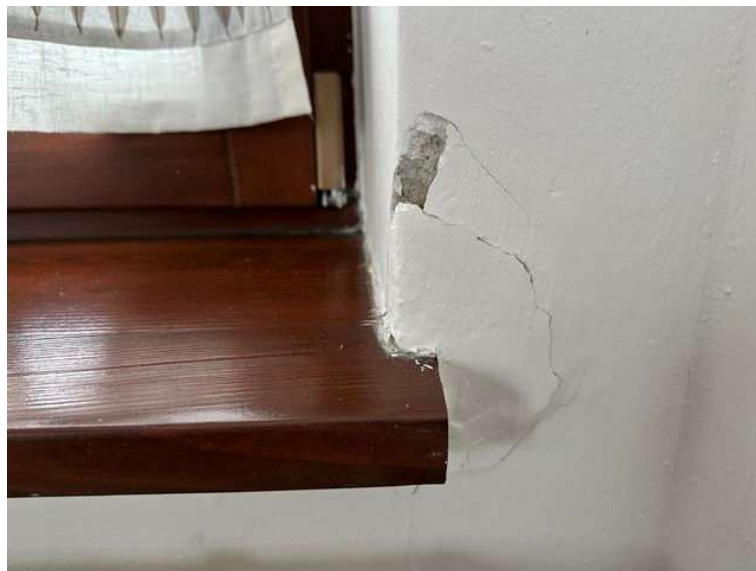
Foto 19: Pohled na opadávání omítek v oblasti ostění a parapetu v pokoji č. 11
