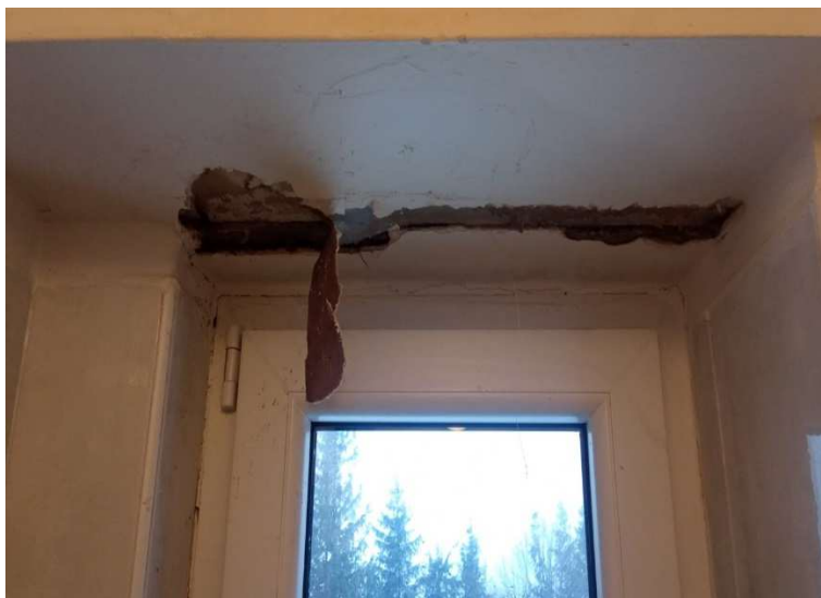
Foto 2: Pohled na zřícení části podhledu nadpraží vlivem vlhkosti (zasláno dodatečně provozovatelem Jiřím Valentou)
