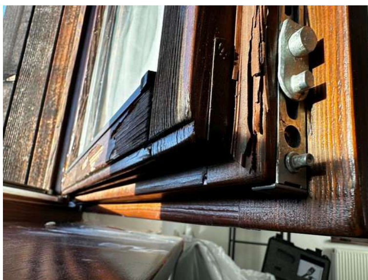
Foto 22: Pohled na zcela chybějící těsnění funkční spáry, degradace okenního rámu
