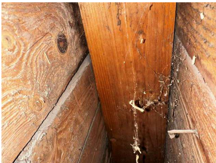
Foto 14: Pohled do uzavřené vzduchové vrstvy mezi nosnými dřevěnými sloupky, bez viditelných stop degradace
