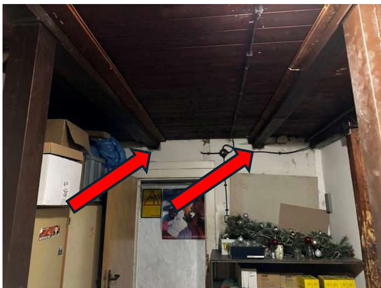
Foto 27: Pohled na místa s podezřením na chybějící podepření svařence
