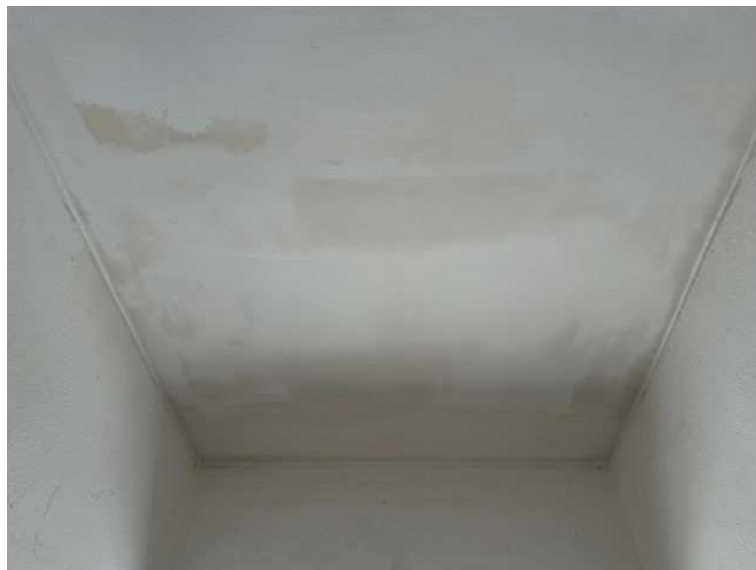
Foto 8: Pohled na zapravení sondy S1
